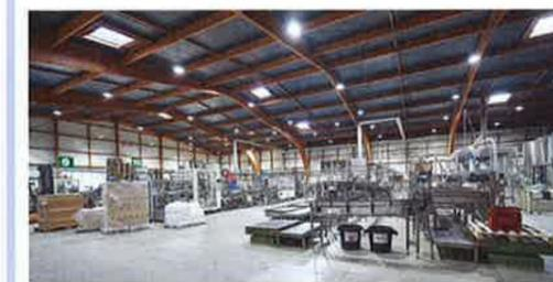
L'éclairage leds installé au printemps 2016 améliore le confort visuel en production et assure une économie de 20 000 kWh/an. Ajouté à la sectorisation de l'allumage de la halle de conditionnement, le ROI est de cinq ans.
